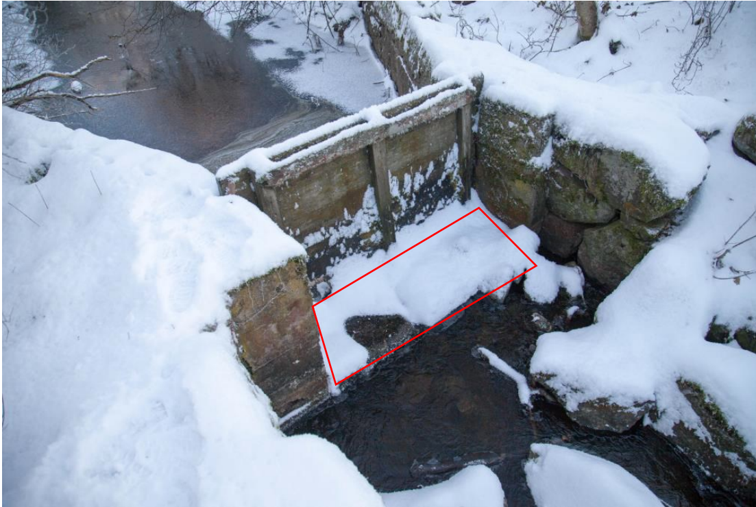
Figur 5 Betongtröskeln på bilden (markerad i rött) finns i botten av nuvarande dämme och måste avlägsnas eftersom den utgör ett vandringshinder. Det samma gäller också dammluckan.
